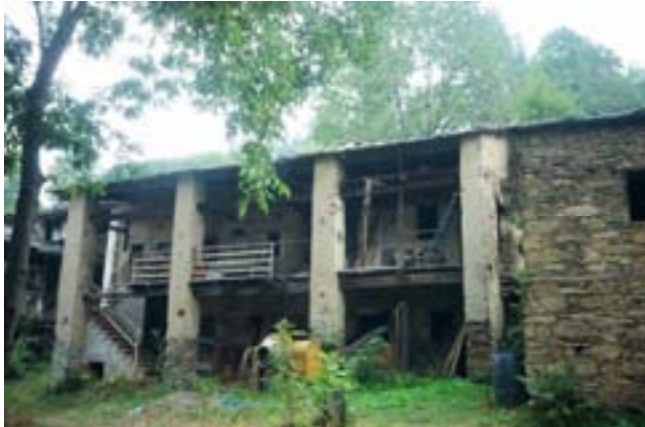
240. Edificio tradizionale a pilastri della Val d'Angrognà
