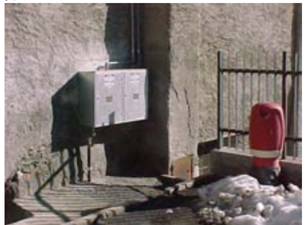
89.90. alcuni interventi invasivi su edifici
