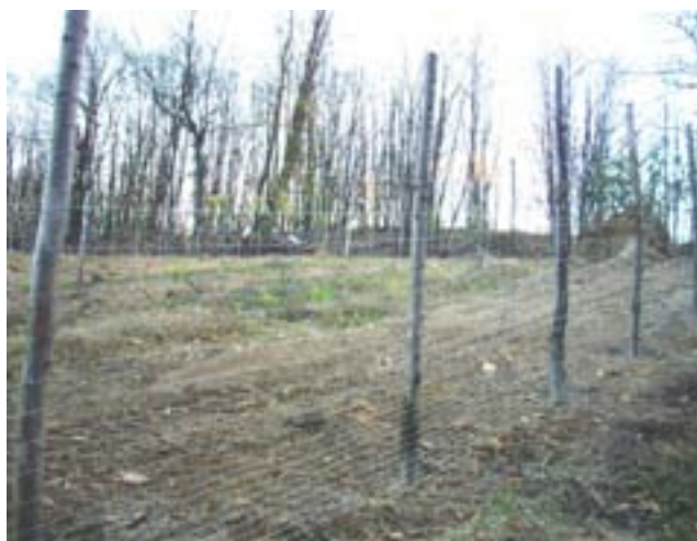
Fig. 6- Recinzione con pali in castagno e rete zincata per la protezione dalla fauna selvatica (Lusernetta). Impatto modesto e rete quasi impercettibile a distanza.
