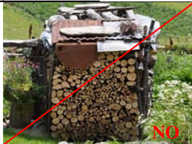
Fig.2 -Legnaia ricoperta con ondulati ed altri materiali di recupero più o meno arrugginiti
