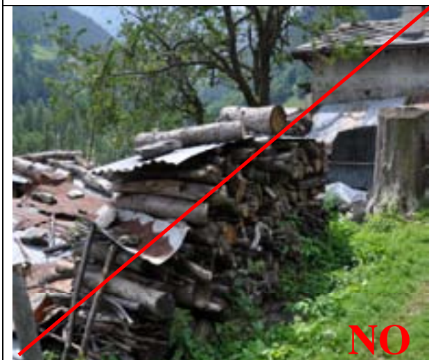
Fig.3- Coperture arrugginite e mal posizionate
