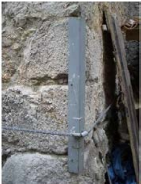
Esempi di cerchiatura esterna per tirantatura a cavo
