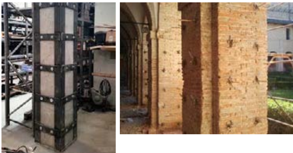
Esempio di cerchiatura metallica e consolidamento per morsetti tenditori e iniezioni di resina
