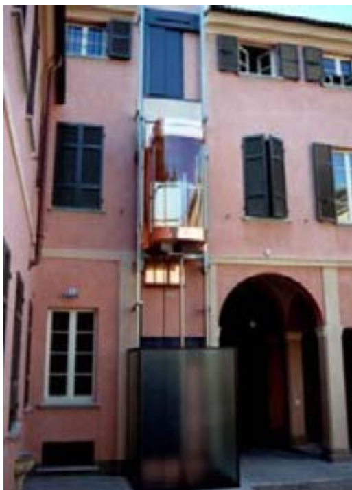
Inserimento di ascensore esterno in edificio storico.
