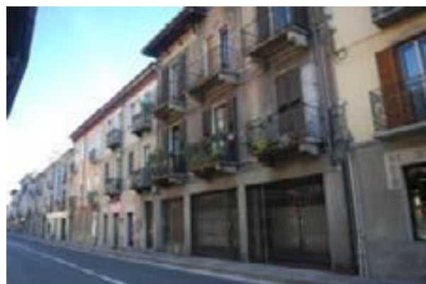
Bussoleno, Via Traforo
