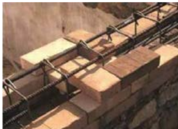
Esempio di cordolo in muratura armata
