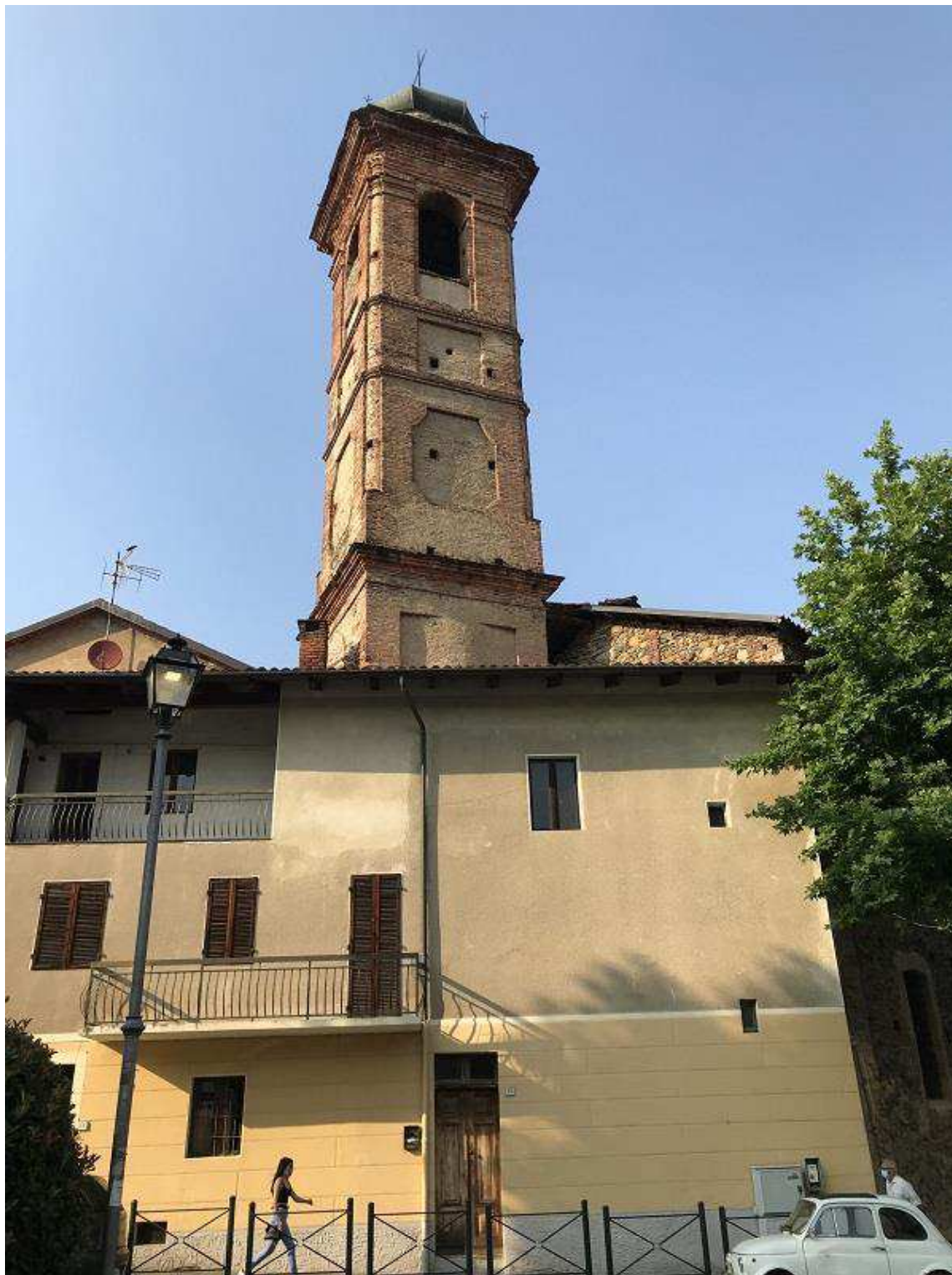
Foto 8: vista della torre campanile da Piazza Molines
